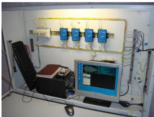
Основные элементы систем геомеханического мониторинга «Prognoz ADS» и «Prognoz S»
