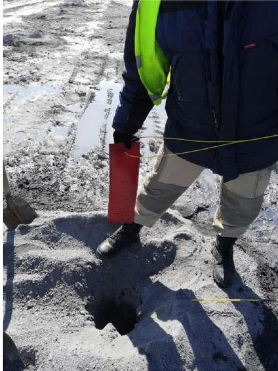
Рис. 2.8. Размещение маяка из пластика в специальной скважине
