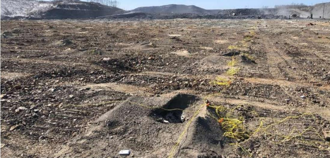
Рис. 3.46. Вид поверхности заряженного блока на уступе высотой 5 м
