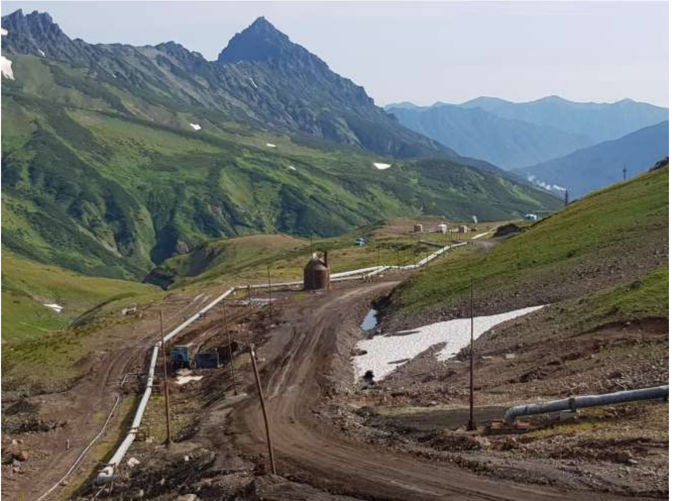
Рисунок 3.9 – Переход через дорогу трубопровода от скважины Гео-1
