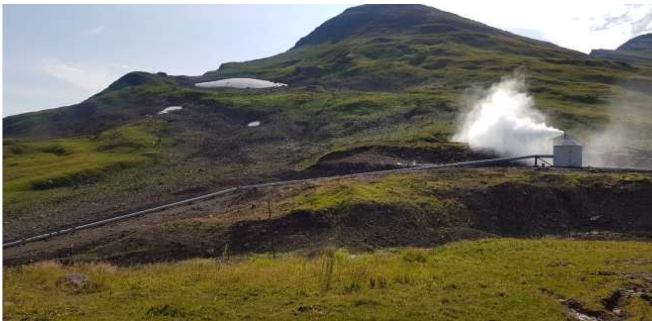
Рисунок 1.4 – Трубопровод с нисходящим потоком от скважины Гео-1 Мутновского геотермального месторождения, Камчатка
